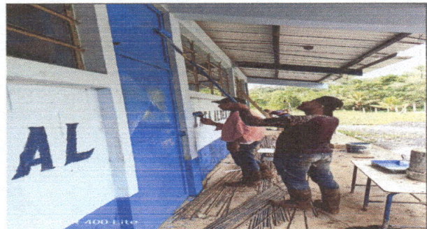
Foto 4: Remozamiento en pintar interior y exterior del establecimiento.
