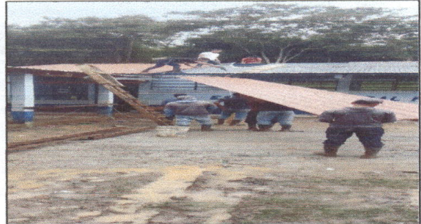
Foto 2: Remozamiento de techo de lámina del establecimiento.
